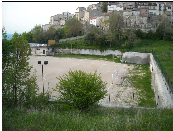
La paratia di pali che protegge il campo dalla frana de i "Fossi" in realtà obbliga il campo a 50 mt di larghezza e per il campionato di Promozione la larghezza deve essere di 60 mt
