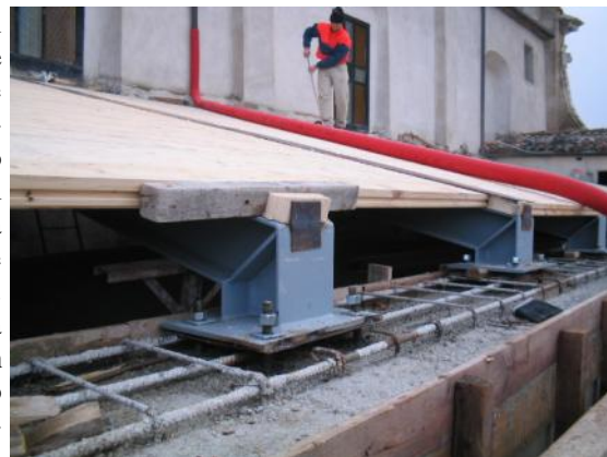
La nuova copertura del tetto con l'evidenza dell'attacco
