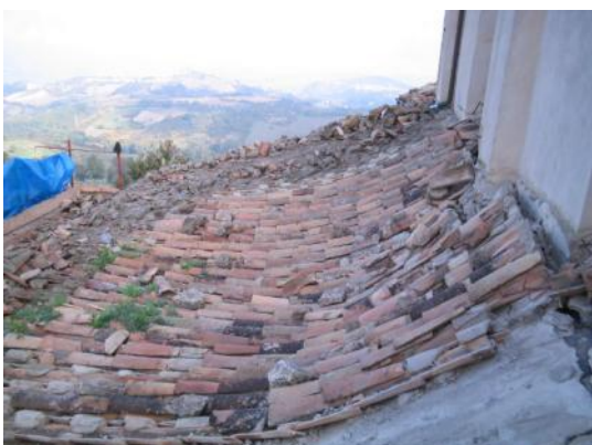
Così era il tetto della navata di sinistra
