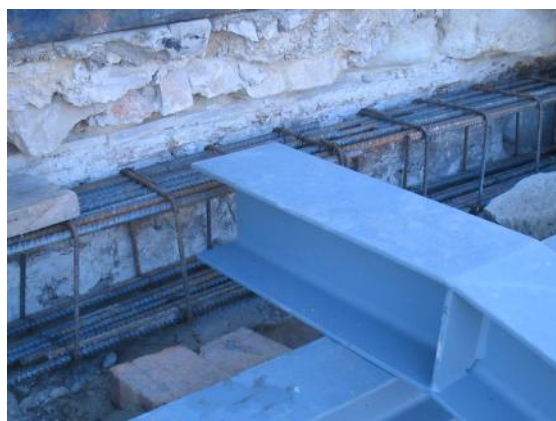
Particolare della testa della nuova trave in ferro con l'innesto nello pseudo cordolo
