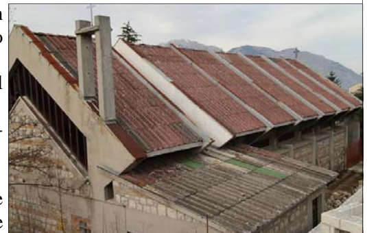
Il tetto in eternit della chiesa di San Rocco
