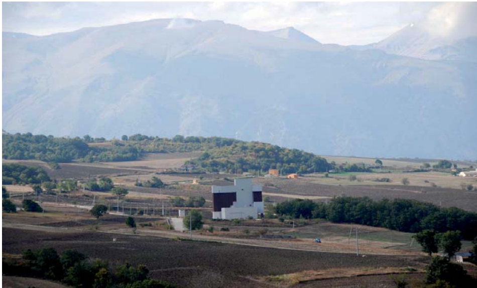
5 – Il mangimificio in stato di abbandono, l'ecomostro situato nel centro della Piana dei Calderari.
